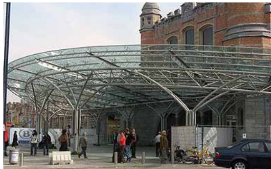
figuur | luifel stationsgebouw (www.projectgentsintpieters.be)
